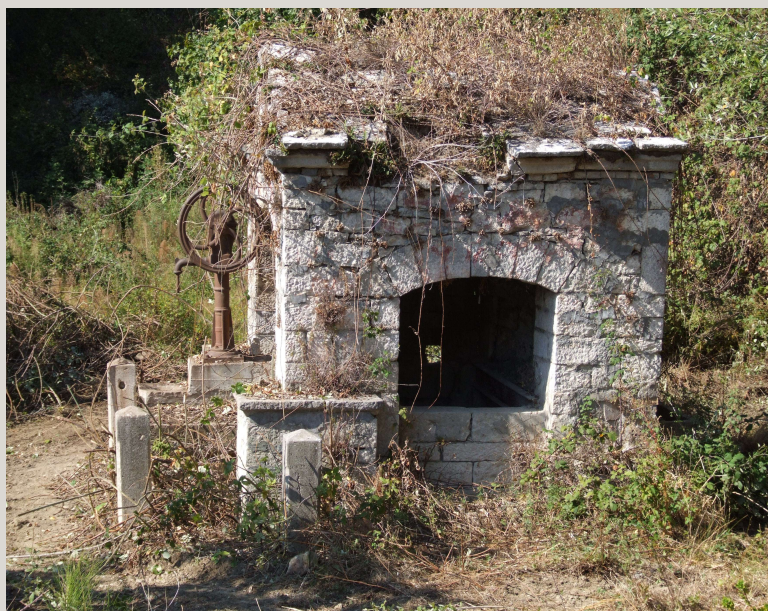
Castelbottaccio – Pozzo con casetta e pompa. Il pozzo è coperto da una casetta realizzata con elementi in pietra ben squadrate. La facciata è caratterizzata da una nicchia con arco e da una cornice di chiusura in pietra sagomata che rimarca la linea gronda ed il timpano della copertura a due falde.
