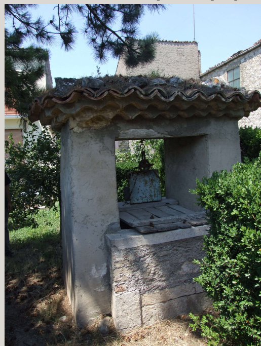
Jelsi – Pozzo coperto con parapetto.
