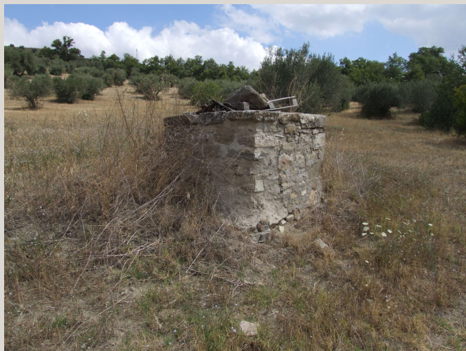
Macchia Valfortore – Pozzo con parapetto e botola.
