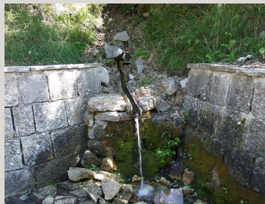
Capracotta – L'acqua, captata direttamente dalla vena della sorgente, viene trasportata tramite una conduttura scavata nel tronco di un albero al punto di approvvigionamento (due metri a valle sulla strada che da Capracotta conduce a San Pietro Avellana).
