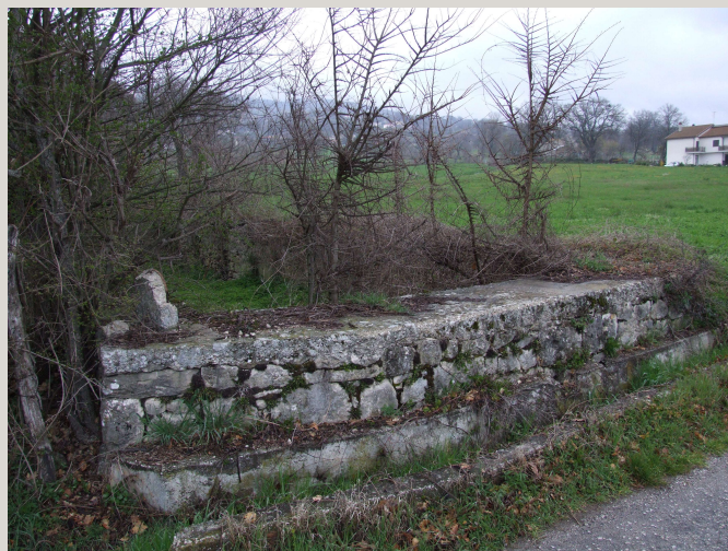
Macchiagodena – Piscina di raccolta delle acque superficiali.
