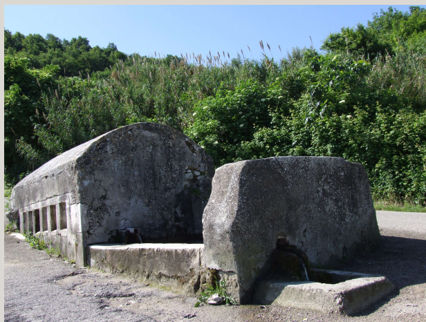
Palata – Fontana che pone in evidenza il serbatoio di alimentazione coperto con struttura voltata.
