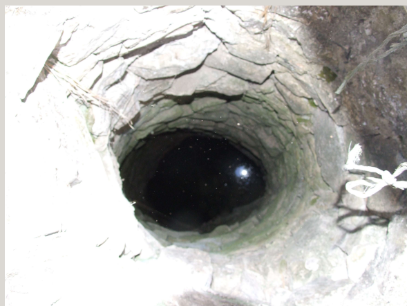
Macchia Valfortore – Pozzo con parapetto e botola: interno del pozzo con profilo ellittico.
