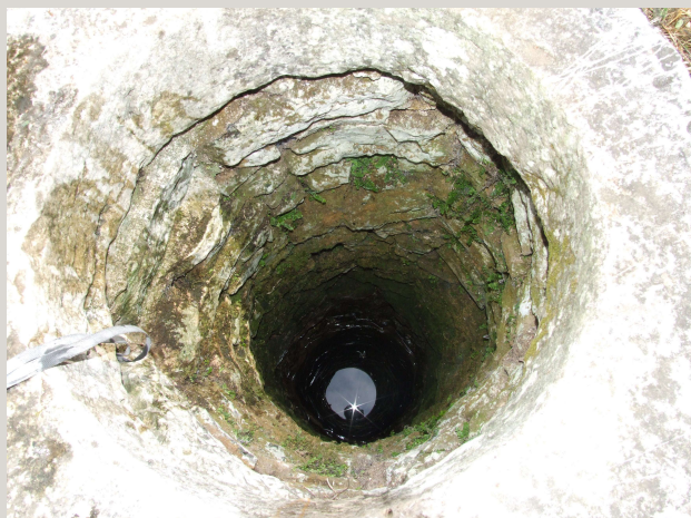
Miranda – Pozzo con parapetto, veduta dell'interno. Lungo il perimetro interno del paramento sono state lasciate delle buche a distanza regolare per permettere ad una persona di potersi scendere per le normali operazioni di manutenzione senza adoperare una scala a pioli.
