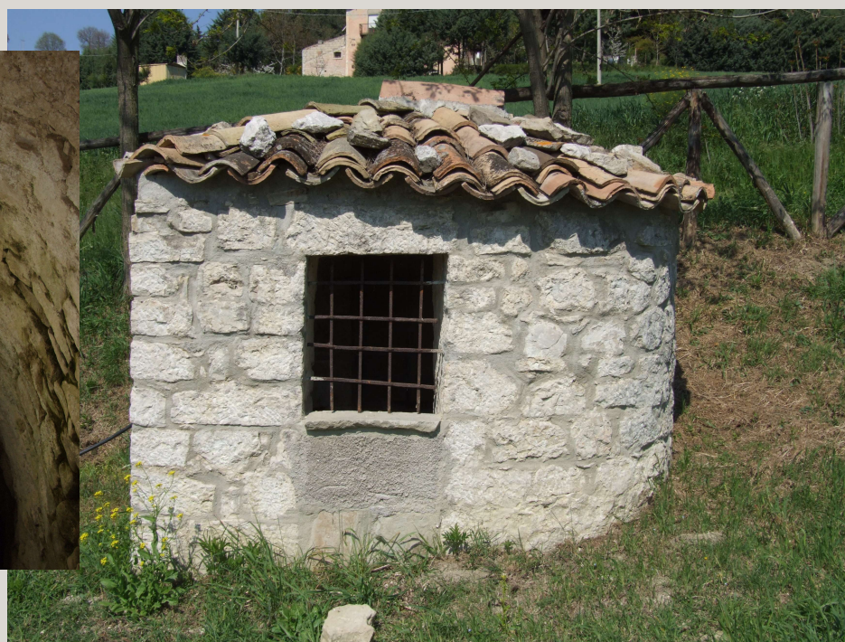
Fossalto – Pozzo con casetta: piccola costruzione coperta con coppi di laterizio ( "pinci" ) a protezione del pozzo.
