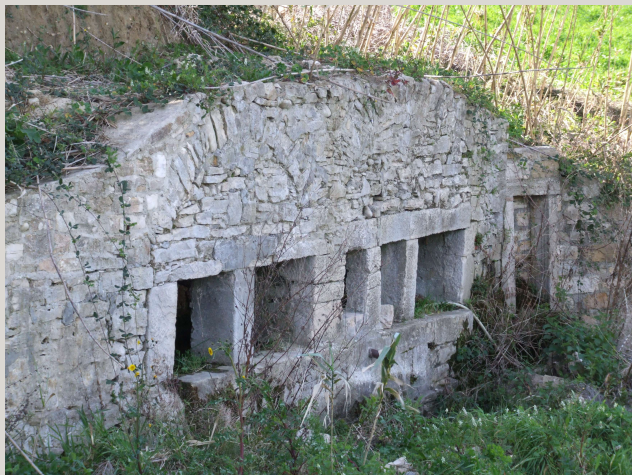
Acquaviva Collecroce – Tipologia di fontana a fronte rettangolare con leggera bombatura sull'estradosso. Sul fronte si aprono cinque nicchie per l'approvvigionamento dell'acqua. Sono visibili due archi di scarico posti sopra gli architravi delle nicchie.
