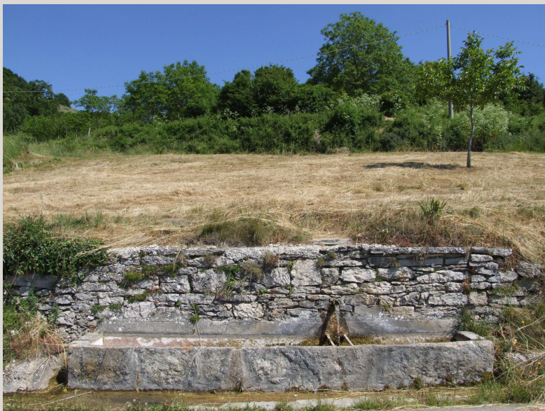
Carovilli – Tipologia di fontana a fronte rettangolare con vasca in cordoli di pietra, cannella in metallo e piattine di ferro per l'appoggio del recipiente.
