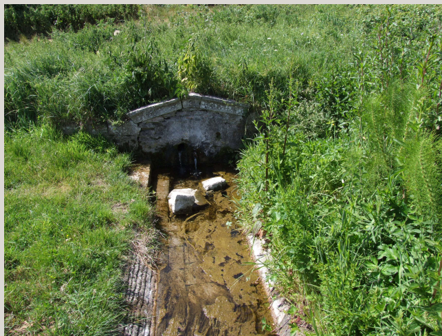
Riccia – Fontana in pietra con timpano sormontato da cornice sagomata e vasca a due cannelle seguita da lavatoio.
