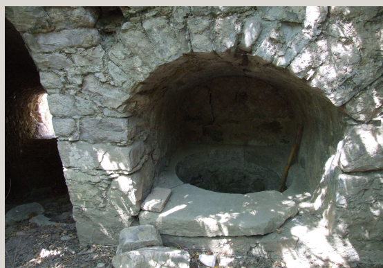
Macchia Valfortore – Mulino ad acqua - Pozzo situato sul percorso della galleria interna che congiunge il mulino superiore a quello inferiore. Il pozzo è stato ricavato dentro una nicchia della galleria per non ostacolare il transito degli asini durante il trasporto della farina o delle granaglie da macinare.
