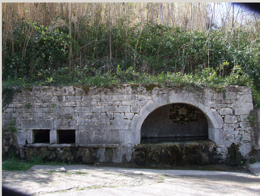
Acquaviva Collecroce – Tipologia di fontana a fronte rettangolare con vasca in nicchia voltata. Il fronte è caratterizzato da un paramento in pietra di buona fattura su cui si aprono tre nicchie: le due nicchie più piccole sono sormontate da architrave e venivano utilizzate come abbeveratoio per le pecore; la terza nicchia sormontata da una struttura voltata accoglie la vasca della fontana per tutti gli altri usi.
