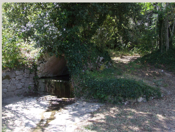
Montagano – Fontana in nicchia con volta a sesto acuto. Sulla struttura voltata della fontana si è perfettamente ambientato un albero di discrete dimensioni.
