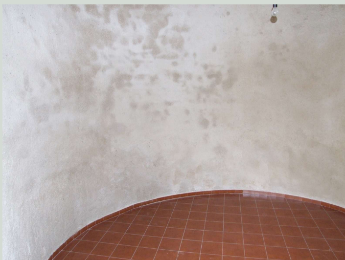
Macchia Valfortore - interno della camera di carico della nevia. Durante i lavori di ristrutturazione del palazzo la nevia è stata in gran parte riempita.
