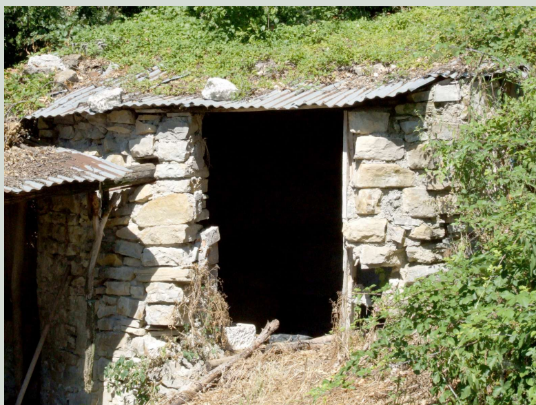
Macchiagodena – Neviera di campagna circondata da una vegetazione rigogliosa al fine di mantenere in ombra il fabbricato e ridurre al minimo l'irraggiamento solare. Allo stato attuale viene utilizzata come annesso agricolo.
