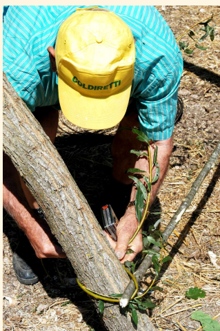
L'ancoraggio degli elementi avviene utilizzando rami di salice fresco ritorto.
