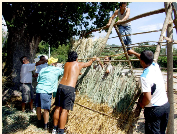
Le fascine vengono sistemate sull'intelaiatura lignea partendo dal basso, per sovrapposizione successiva in modo da favorire lo scivolamento delle acque piovane.
