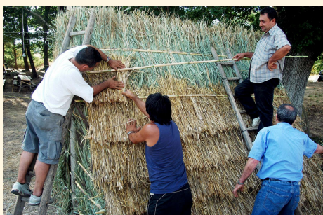
Operazione di fissaggio delle fascine.
