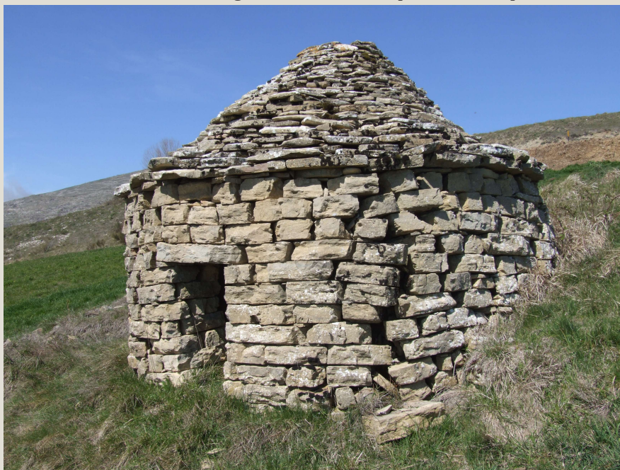
Agnone - Trullo con copertura conica più accentuata.
