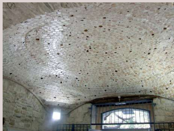
Volta realizzata con pignatelli in terracotta.
