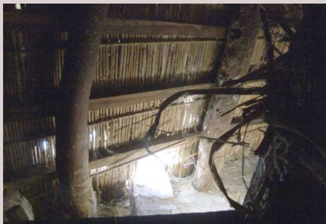
Comune di Pietracatella – Sottotetto realizzato con travi di legno e cannucciato.
