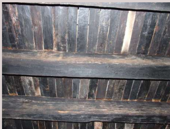
Solaio in legno.
