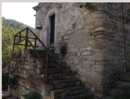
Comune di Gambatesa Scala di collegamento con loggia .
