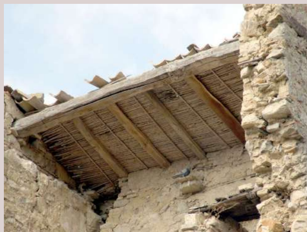
Comune di Macchia Valfortore – Tetto in legno con cannucciato.
