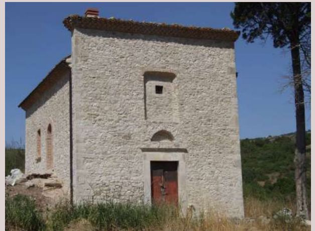
Comune di Morrone del Sannio – Dopo l'intervento di recupero.
