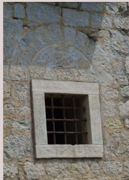
Cornice di finestra in pietra sormontata da un arco di scarico.
