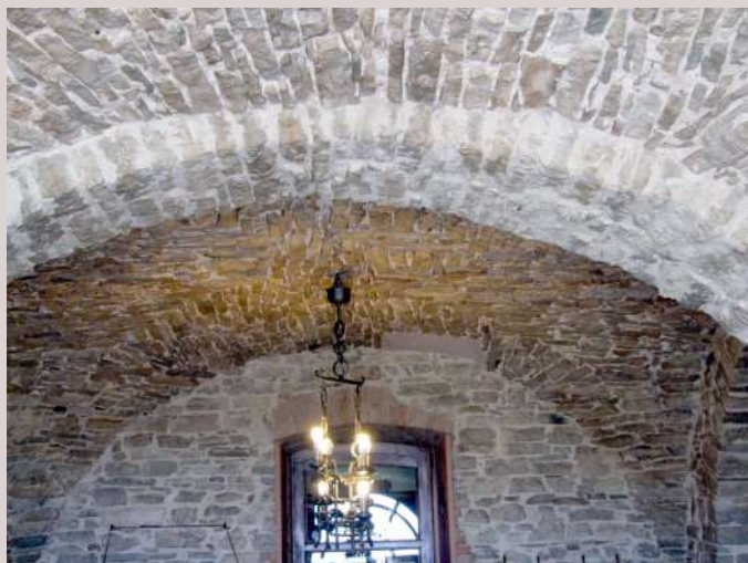
Volta realizzata con conci di pietra.
