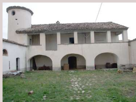
Comune di San Massimo – Residenza dei braccianti.
