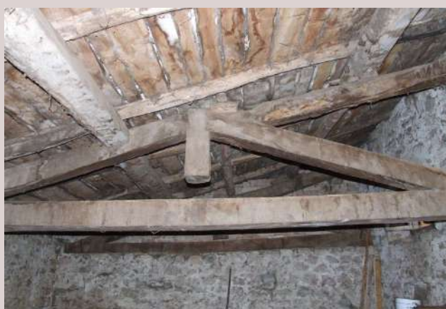
Comune di San Massimo – Casa a corte – Capriata in legno del tetto della stalla.
