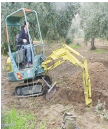
Foto 1 - Escavatore meccanico per apertura profili
